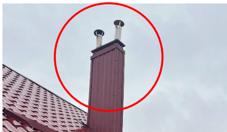
установка зонтов на дымовых каналах
