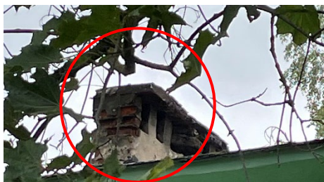
разрушенный оголовок дымовых и вентиляционных каналов
