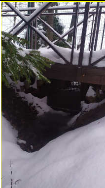
Рисунок 1.2.1 – Общий вид автоматического шлюза в истоке ручья без названия
